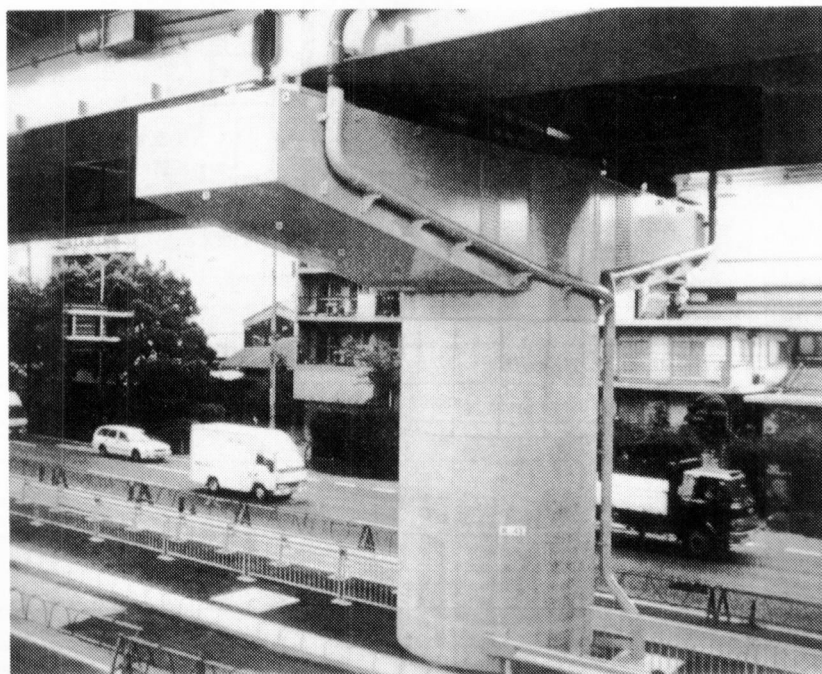
写真4. 1. 1-1 再構築橋脚完成写真
