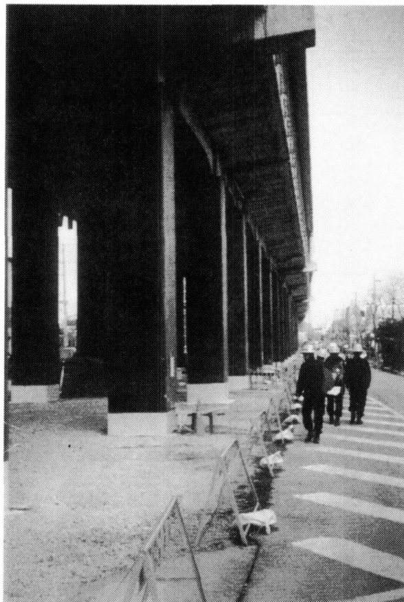
写真 4.1.2-1 鋼板巻き補強後の鉄道高架橋
