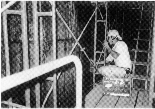
プライマー工
