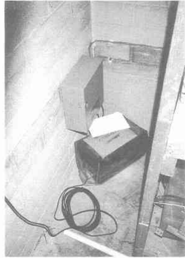
写真 3.2.2 ニューホール地震観測点設置状況
