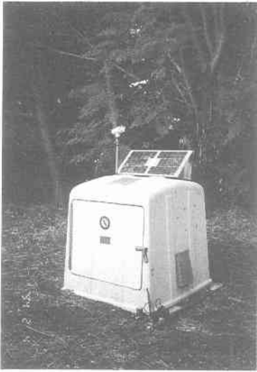
写真 3.2.1 タルサナ地震観測点設置状況
