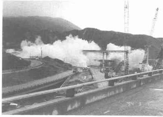
写真 5.5.9 爆破を用いた橋梁の撤去 9)
