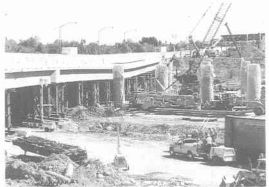
写真 5.5.33 東行き橋梁の再建工事 1)
