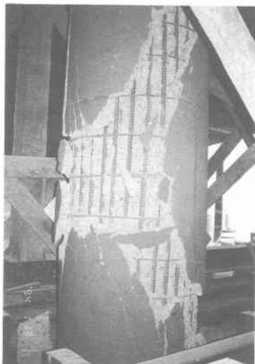
←写真 5.5.18 P4 橋脚の被害せん断破壊（橋脚にせん断ひび割れが生じた。帯鉄筋の間隔は 30 cm で、主鉄筋に比較して明らかに帯鉄筋が少ないのがわかる） 2)
