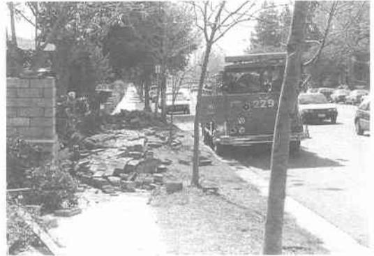
写真 5.5.56 沿道ブロックの歩道側への倒壊 2)
