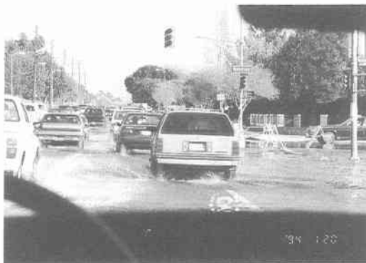
写真 5.5.54 水道管の破断による道路の冠水 2)
