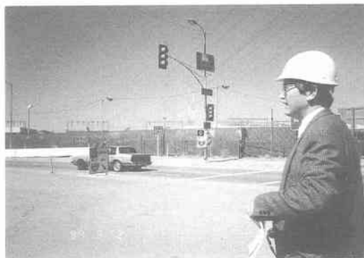
写真 5.6.1 I-10 の迂回路 (フェアファックス通りからの入口。街路灯の上側の標識が迂回路の案内標識。下側の標識と車の手前の標識が HOV 優先迂回路であることを示している) 1)
