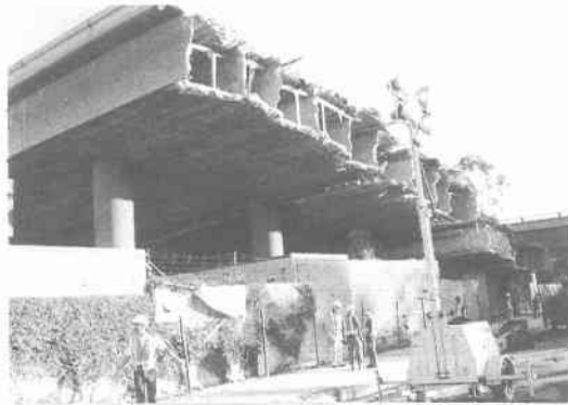
写真 5.5.20 I-10 ラシェネガ/ベニス地区高架橋（手前がラシェネガ大通り） 2)
