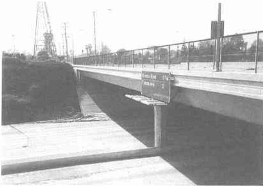
写真 5.5.40 S-118 バルボア橋
