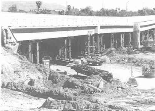
写真 5.5.32 西行き3径間連続橋の補強 1)
