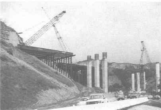
写真 5.5.14 ガビン・キャニオン橋の復旧工事の状況（旧道からみた北側の橋脚、橋台の復旧工事の状況。8角形のRC橋脚の構築には鋼製の型枠が使用されていた） 1)
