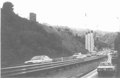
写真 5.5.12 ガビン・キャニオン橋の復旧工事の状況（旧道からみた南側の橋脚、橋台の復旧工事の状況。新設橋脚の柱数は3本となっていた。旧道はI-5の迂回路のため交通量が多かった） 1)
