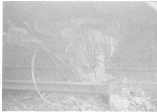
写真 5.5.17 P3橋脚の被害 (橋脚上部でコンクリートが崩壊し、帯鉄筋が少ないため主鉄筋が大きく外方向に座屈した) 2)
