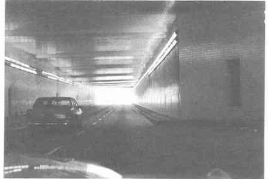
写真 6.8 バンナイズ空港滑走路の下を走るトンネルの内景
