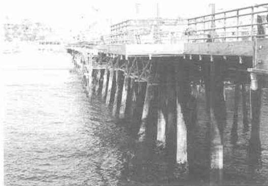
写真 6.6 サンタモニカビーチの突堤式栈橋
