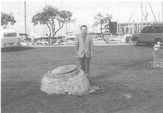
写真 6.3 レドンドビーチのマンホールの浮き上がり
