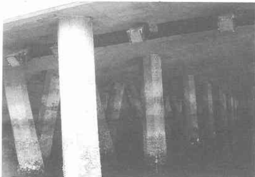
写真 6.2 ロサンジェルス港 B127 岸壁の斜杭の被害状況
