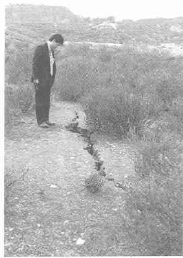
写真 7.3.8 サンフェルナンド下ダム法先付近の縦亀裂 (東京工大 川島一彦教授より提供)
