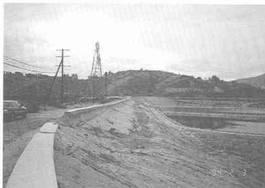
写真 7.3.12 サンフェルナンド上ダムの地震後の状況 ((株)飛島建設 沼田淳紀氏より提供)
