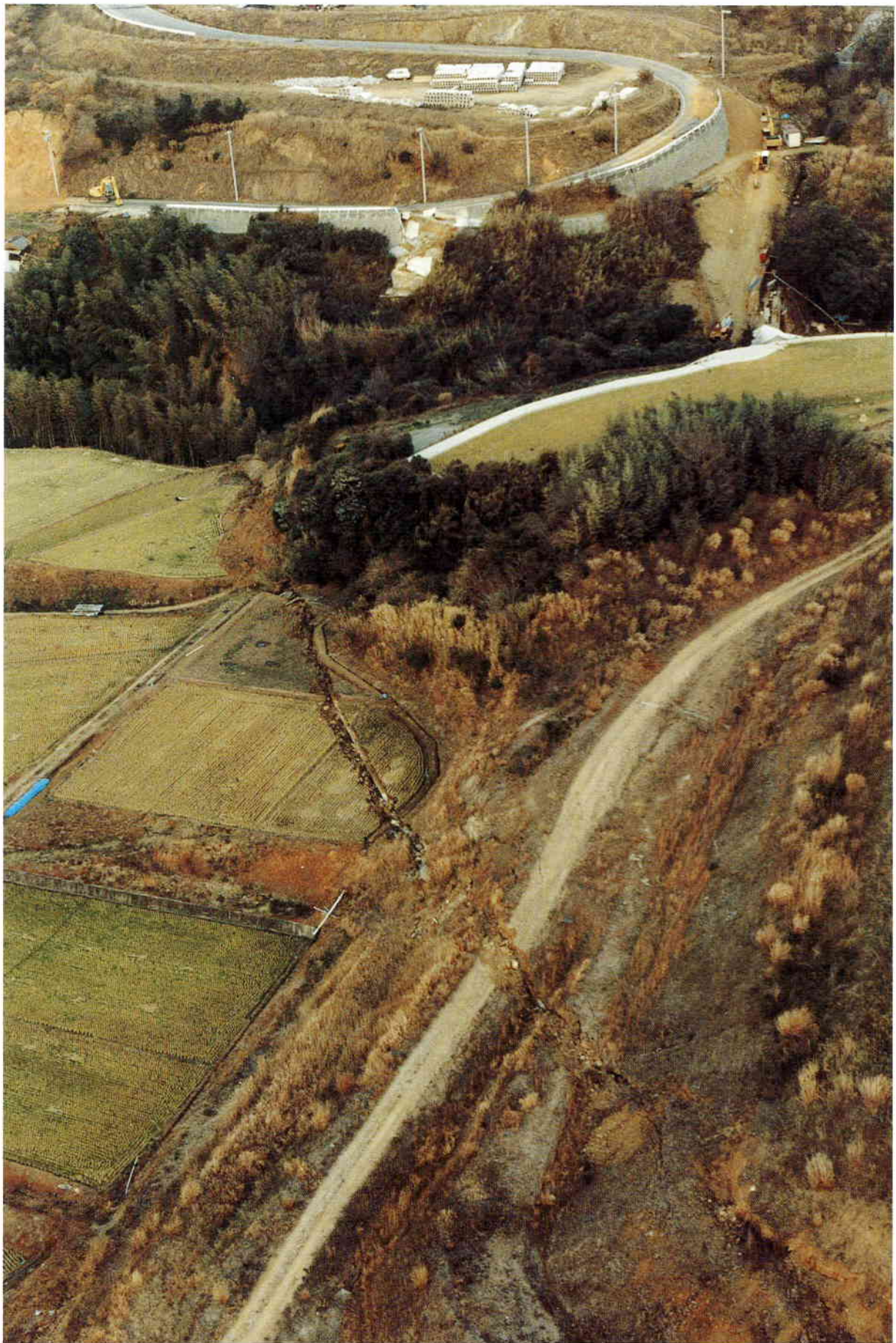
写真-3. 2. 1 北淡町平林に現れた野島地震断層(朝日新聞社、1995年1月18日午後4時頃撮影) 北方を望む
