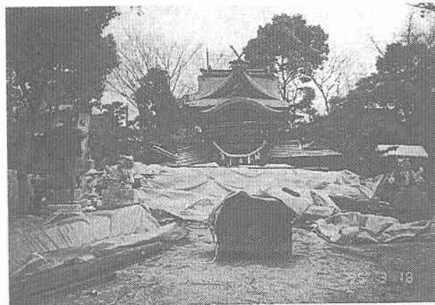
写真-3.2.1 初島大社の倒壊状況
