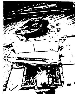
写真-4.7.3 桁との衝突で割れた上沓 (中間支点の530ト可動支承、ローラーもなくなっている)
