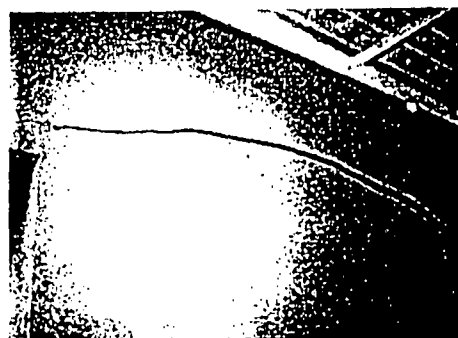
図-5.4.2 き裂発生状況（東面ウェブ）
