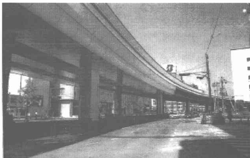
写真-2.7.4 弁天地区復旧後の状況
