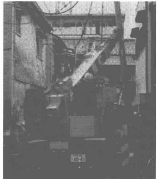
写真-2.6.3 転倒した電柱の復旧状況
