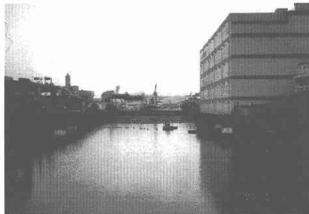
写真-2.3.3 運河を利用した仮沈殿池
