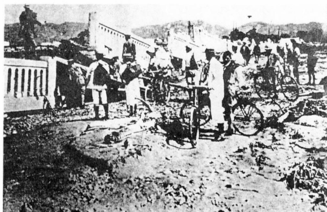
写真1 酒匂川の架橋の落橋 15) (関東地震1923. 9. 1)
