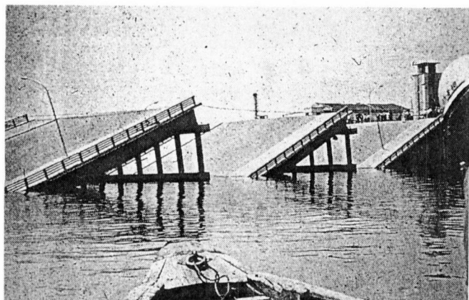
写真5 昭和大橋の落橋 16) (新潟地震1964. 6. 16)
