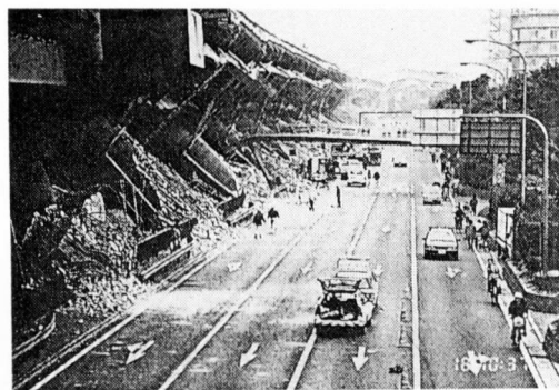
写真14 阪神高速3号神戸線ピルツ橋の倒壊 22) (兵庫県南部地震1995. 1. 17)
