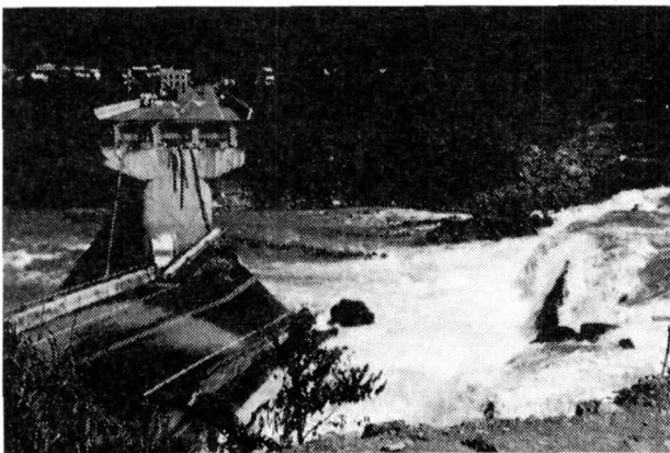
写真-5.2.2 碑豊橋の被害
