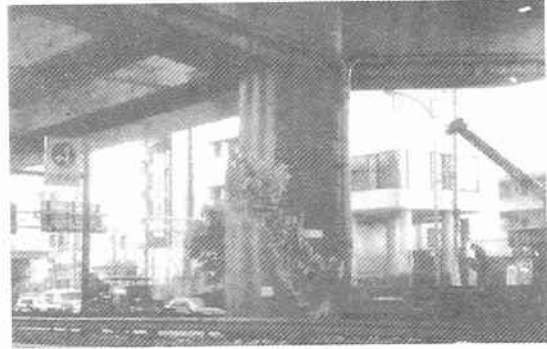
橋脚被害（せん断破壊）
