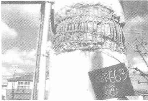
橋脚被害（曲げせん断破壊）
