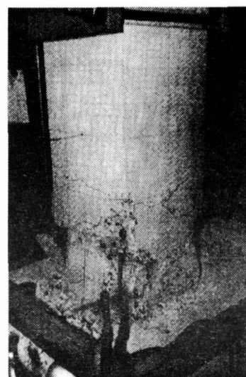
図-5.3.9 曲げ損傷後 せん断破壊 12)
