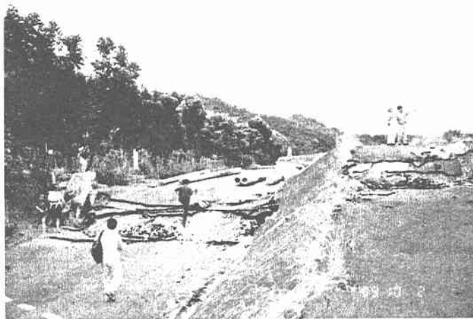
図2.1-1 1999年の台湾集集地震で断層直上にあつて被災した霧峰の河川堤防の状況
