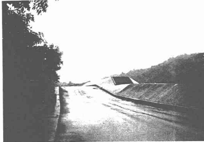
図2.1-2 霧峰の河川堤防が半年後に修復された姿
