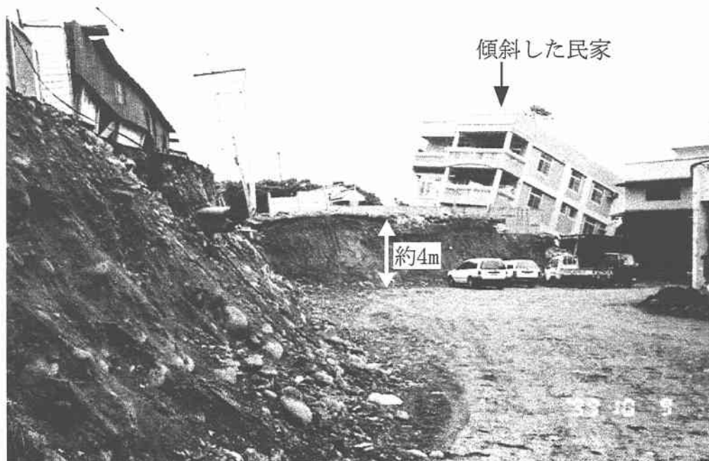
写真13.9.3 一江橋右岸側の断層の地盤隆起
