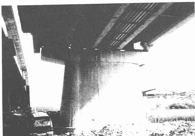
写真 13.6.1.3 旧橋の P 2 橋脚
