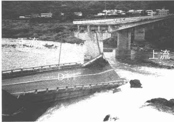
写真 13.7.1.1 卑豊橋の被害
