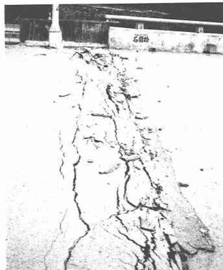
写真 13. 5. 7 卓欄方面線 A1 橋台付近の損傷
