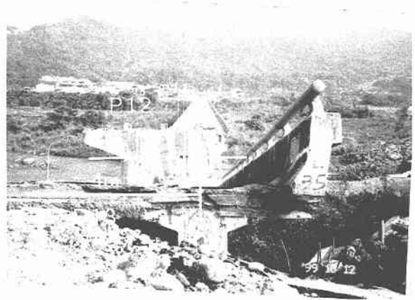
写真 13.7.1.2 卑豊橋 P12, A2 の相対水平変位
