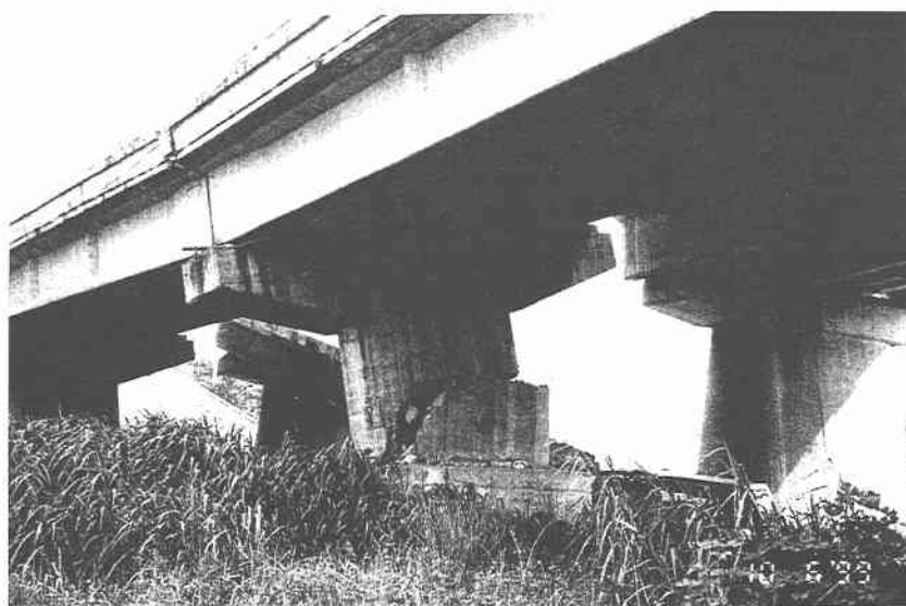
写真 13.6.1.2 烏溪橋の橋脚 (左側が新橋、右側が旧橋)
