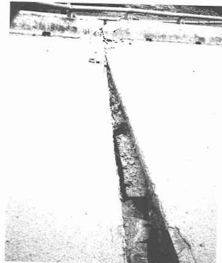
写真 13. 5. 9 卓欄線 P1 上のけたの回転変位
