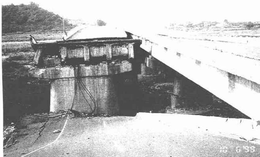
写真 13.6.1.1 烏溪橋の全景 (左側が旧橋、右側が新橋)
