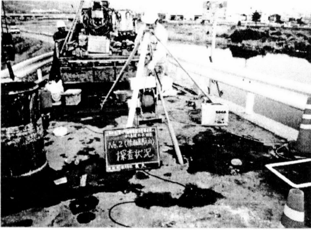
写真-1 観測孔No.2の測定状況
