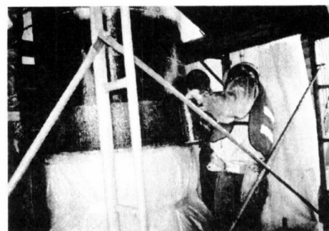
写真-5 炭素繊維シートへの含浸(周方向)
