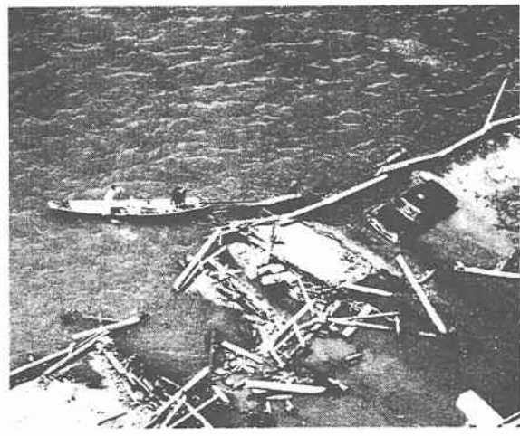
写真 3.7.1-2 松浜橋上に取り残されたタクシー (地盤工学会 1999)
