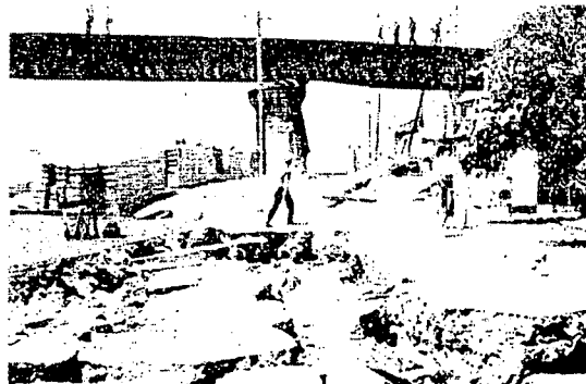
図 3.6.3-4(2) 信濃川橋梁被災状況(左岸川) (土木学会 1966)
