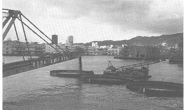
写真-2 中詰材投入
