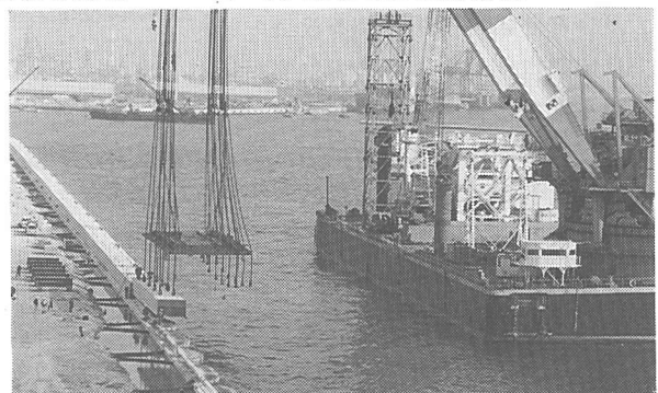
写真-4 上部工の据付
