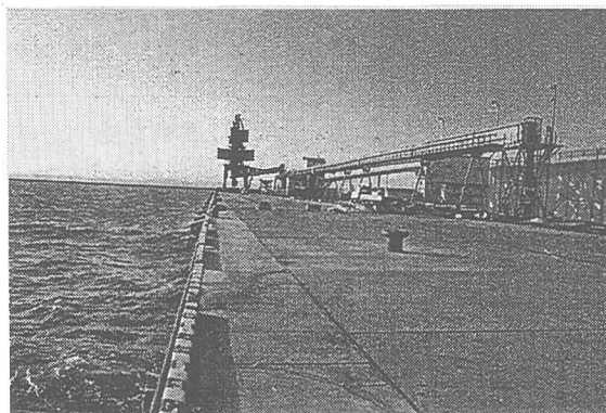
写真-1 b 3埠頭南岸壁-12m（対策有）
