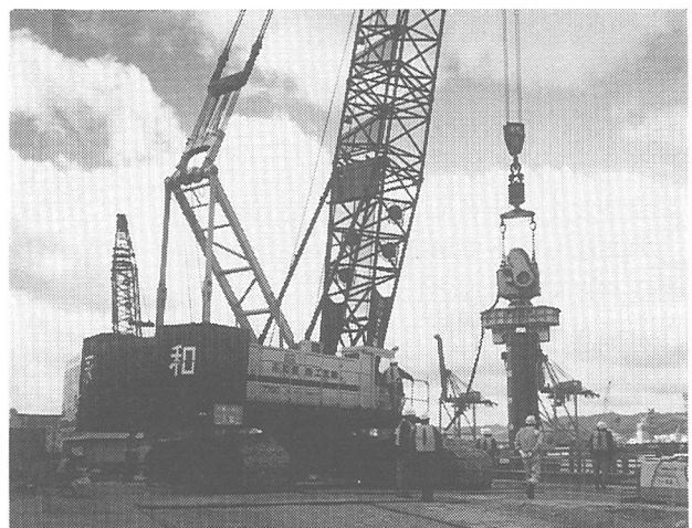
写真-2 鋼管矢板打設工
