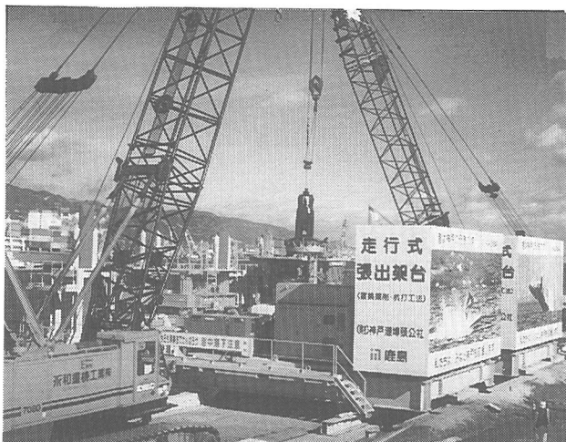
写真-1 置換掘削工
