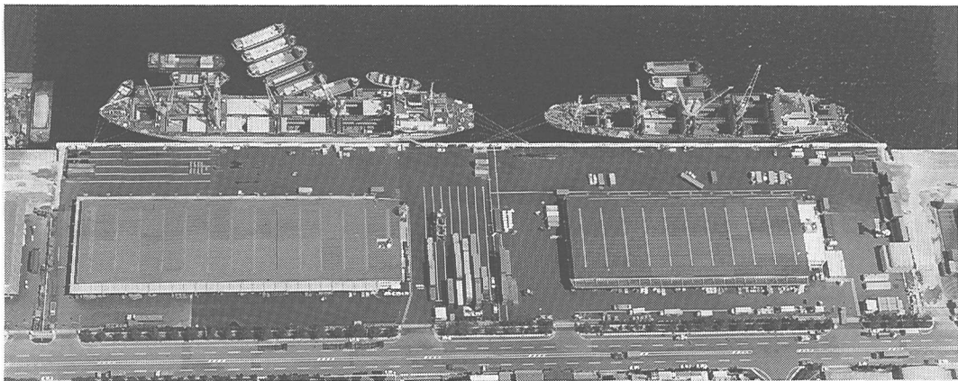
写真-3 竣工(1996年7月1日 第1船着岸)
