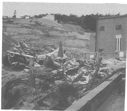
写真-2 西宮市仁川地域の地滑り被害地
