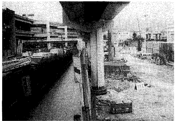
写真-2 復旧状況
