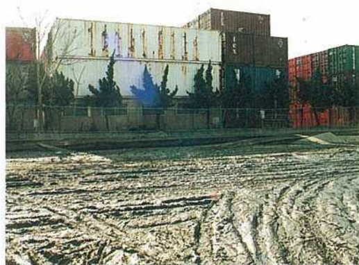
写真-3 液状化による噴砂の堆積(ポートアイランド)
