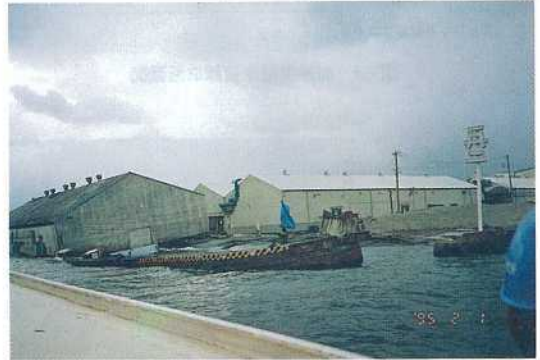
写真-1 兵庫突堤先端
