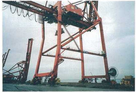
写真-7 六甲アイランドのコンテナクレーン
