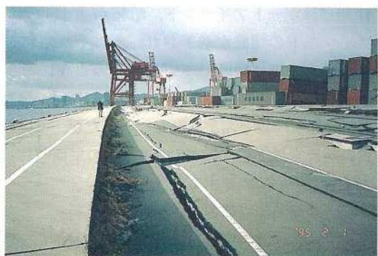
写真-5 摩耶埠頭コンテナバース
