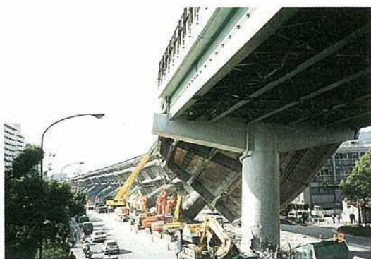
写真-6 阪神高速道路の倒壊
