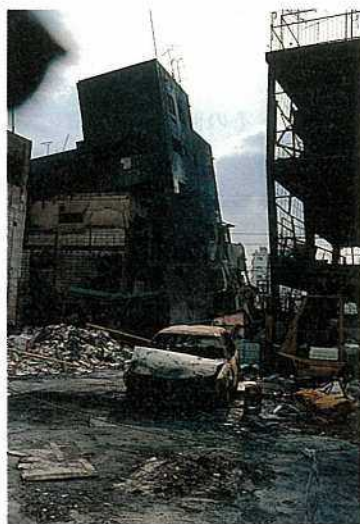
写真-8 火災による延焼と細街路の通行不能
