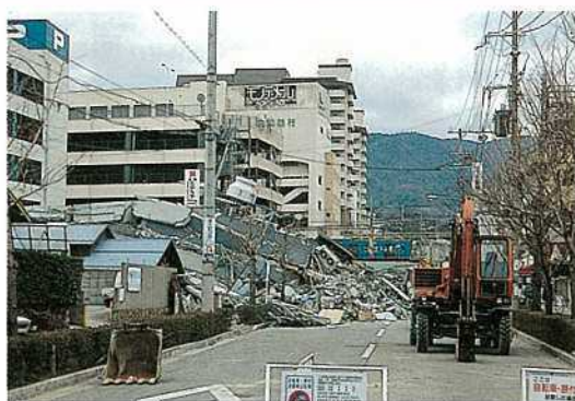
写真-7 建物崩壊による道路通行不能
