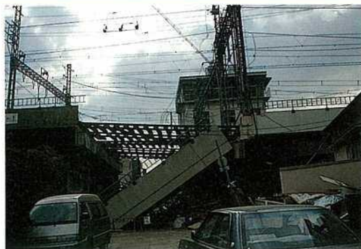
写真-4 鉄道高架橋落下による南北道路通行不能
