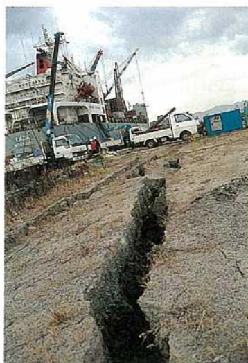
写真-9 六甲アイランド岸壁の崩壊
