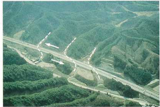
写真-3 山崎断層 (左ずれ) の直上を走る中国道路
