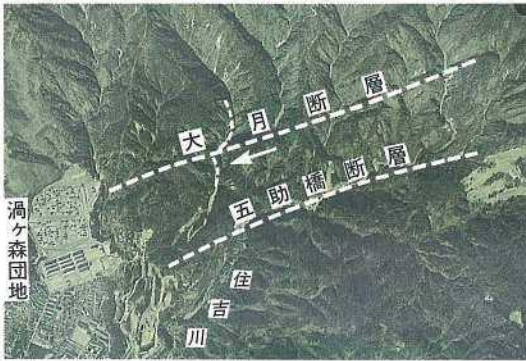
写真-2 五助橋断層と大月断層 (右ずれ)
