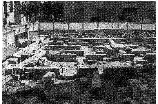
写真-8 十五番館と煉瓦下水道の展示施設（震災後）
