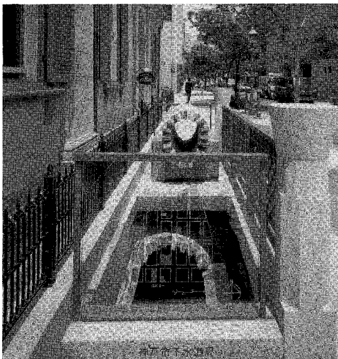
写真-7 十五番館と煉瓦下水道の展示施設（震災前/パンフレット）
