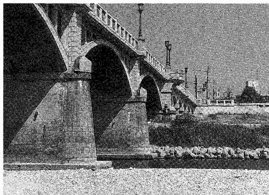
写真-10 武庫大橋（震災後）
