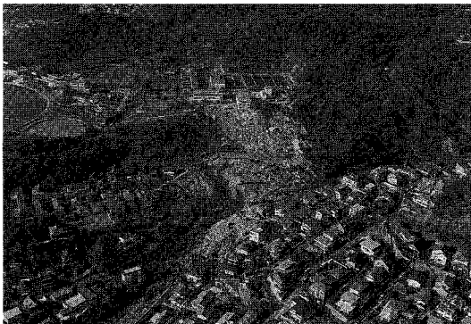
写真-1 被災状況
