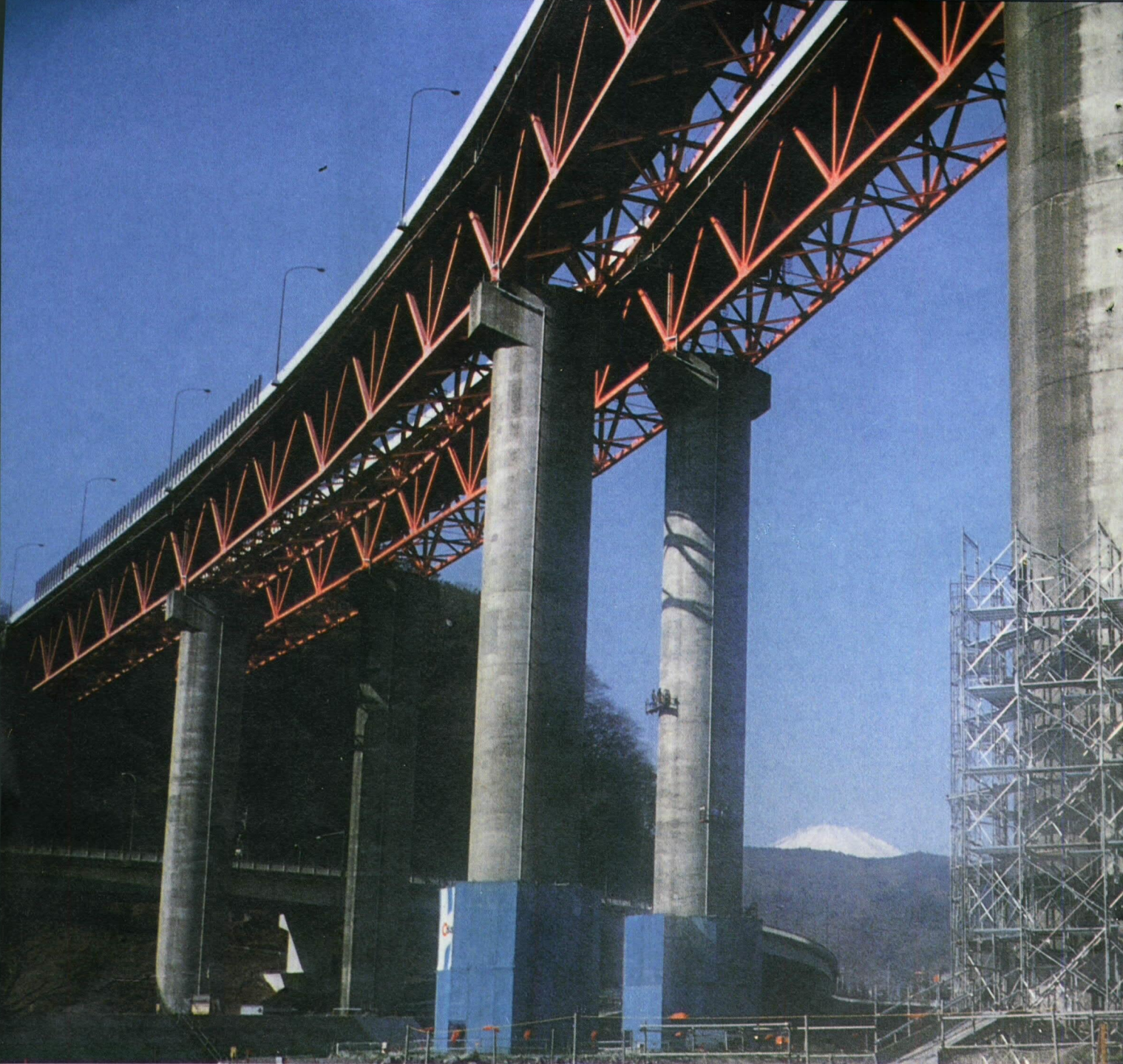
写真-1 東名高速道路酒匂川橋梁
