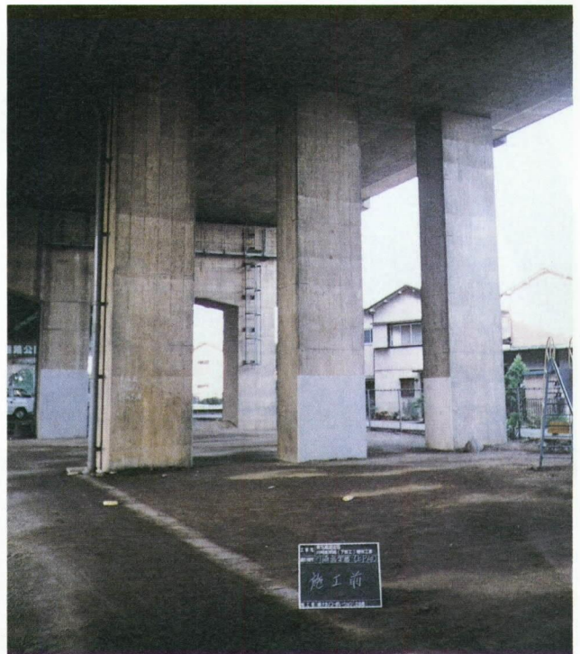
写真-2 東名高速道路川崎高架橋（コンクリート巻立てによる補強）
