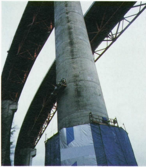
写真-3 東名高速道路酒匂川橋梁(炭素繊維巻立てによる補強)
