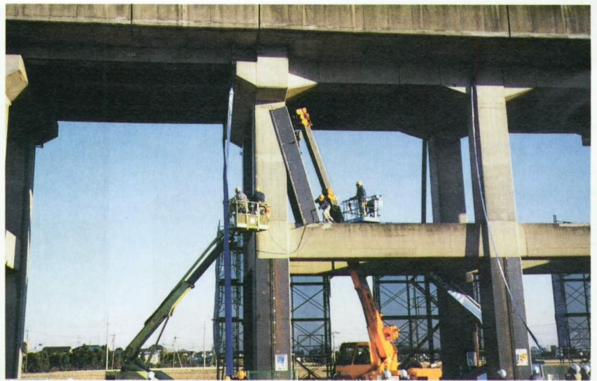
写真-4 東北新幹線高架橋(鋼板巻立てによる補強)
