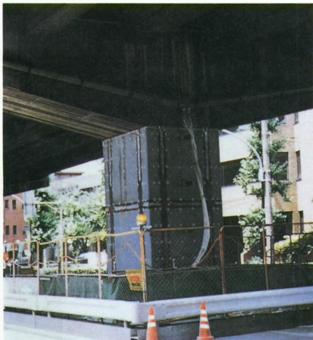
写真-5 首都高速道路(鋼板巻立てによる補強)
