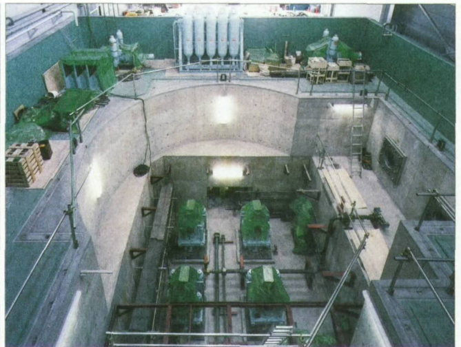
写真-2 工事中の振動台の基礎の状況
