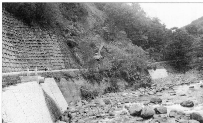
写真-3 県道西山生保内線の復旧状況
