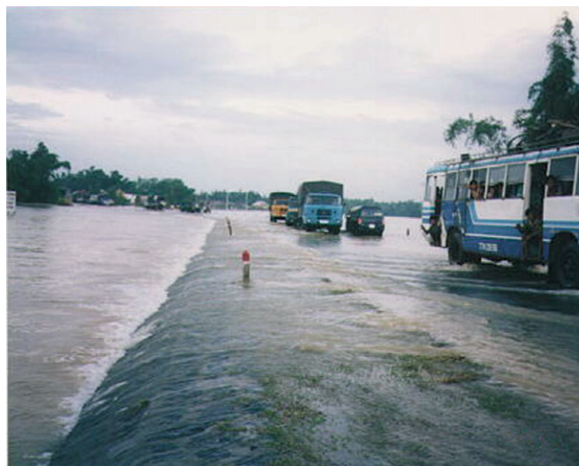
写真-2 国道1号線上を溢水して流れる洪水（1996年11月4日）
