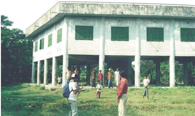
写真-1 サイクロンシェルター
