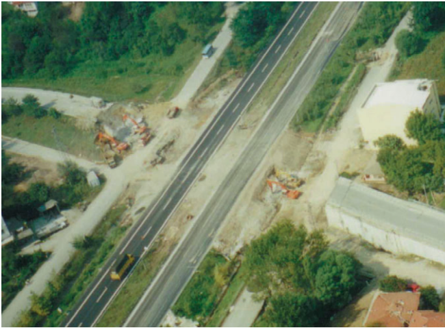
写真-4 アリフィエ橋（高速道路のオーバークロッシング）の落橋
