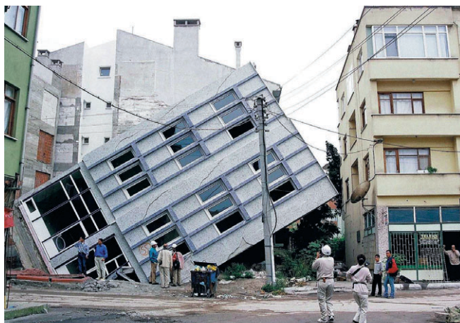
写真-1 アダバザル市内の液状化による建物の倒壊
