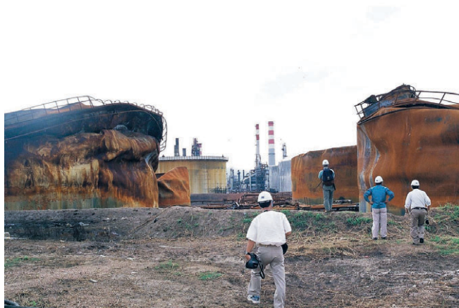
写真-2 トルコ石油精製工場の火災後のタンク
