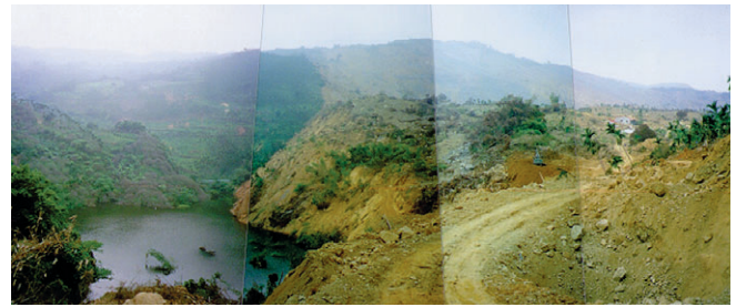
写真-8 南港における大規模斜面崩壊
