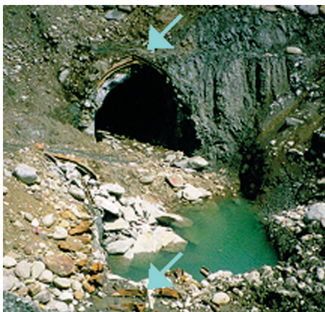
写真-4 取水トンネルの状況
