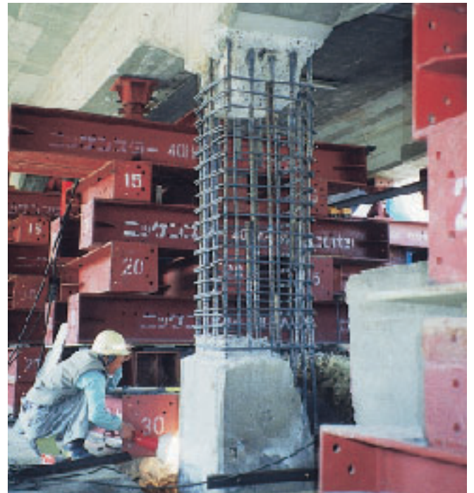
写真-3 高架橋の復旧作業
