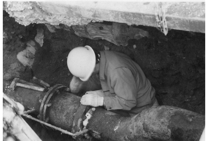
写真 ガス管路の復旧作業
