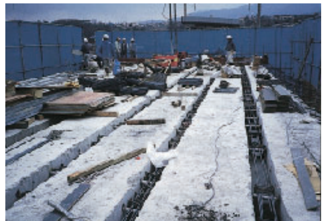
写真-4 PC桁の復旧作業
