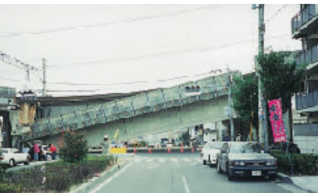
写真-2 落下したPC桁
