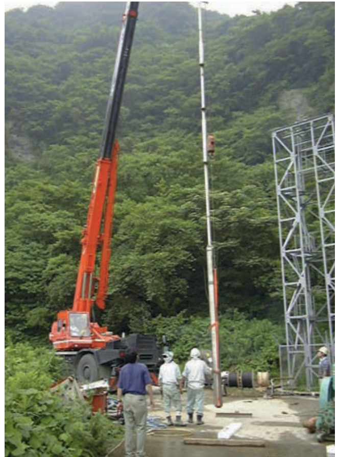
写真-3 海底ポアホール田センサー群の外観
