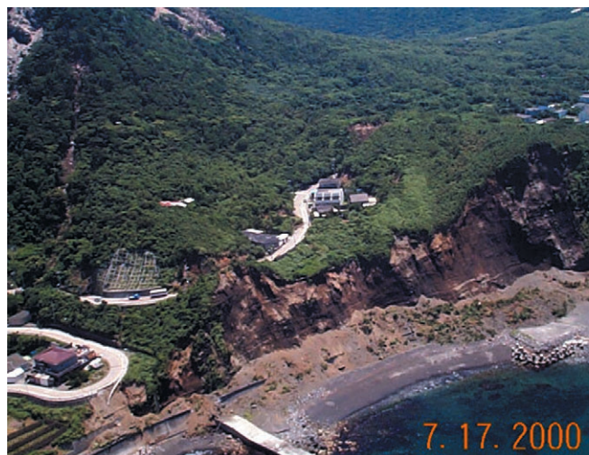
写真-4 新島若郷地区の斜面崩壊現場
