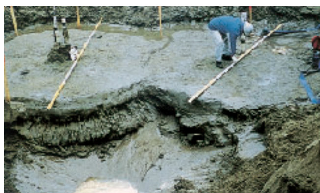
写真-3 掘起こし調査による改良体の確認状況
