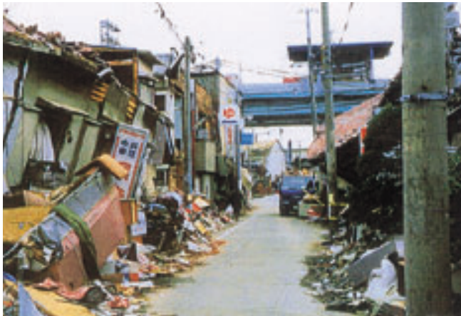
写真-1 屋敷町, 弓場町一番街区間 被災状況
