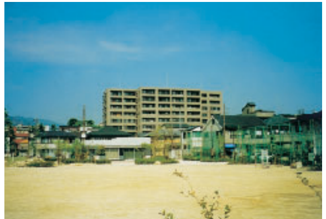
写真-2 森具公園と共同建替え住宅
