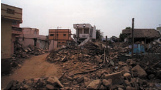
写真-8 ブジ市内の城壁の中（旧市街）の組積造建物の被害
