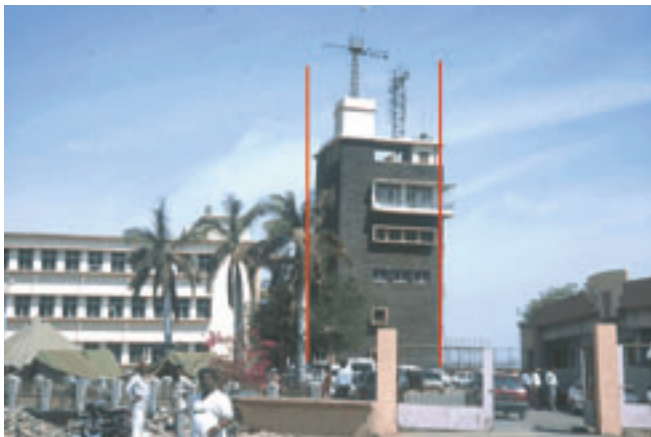
写真-9 海側へ1～2度傾斜した港湾ビル
