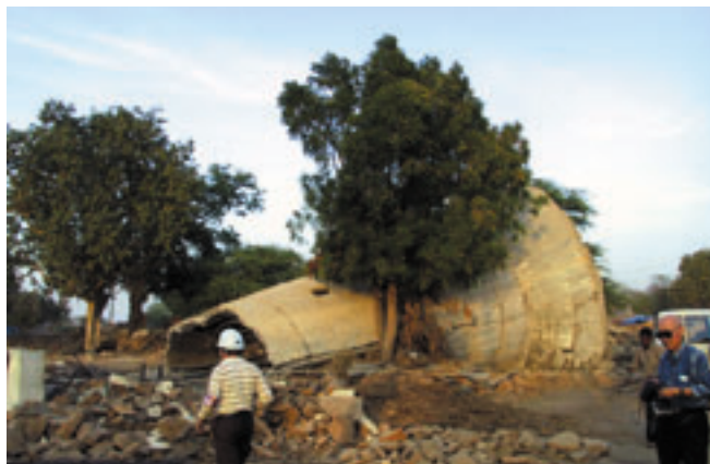
写真-6 チョバリ村の倒壊した給水塔
