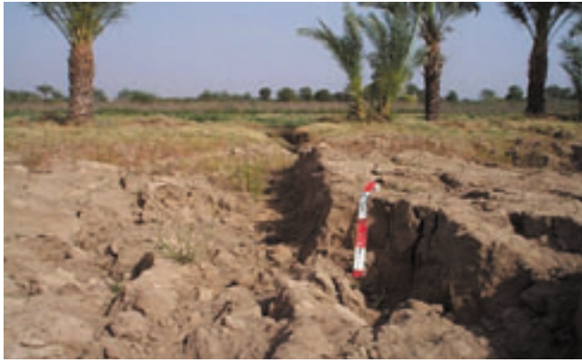
写真-1 畑の中のクラック（南側が50cm程度隆起している）
