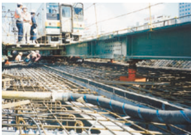
写真-4 高流動コンクリートの打設状況
