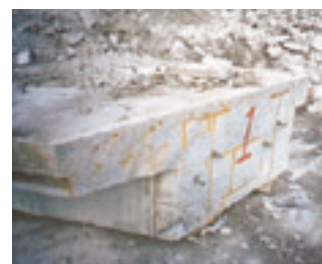
写真-6 補強桁の切断面
