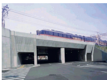
写真-3 清正公架道橋
