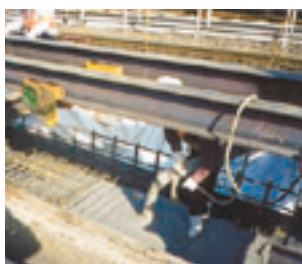
写真-5 試験施工(確認試験)
