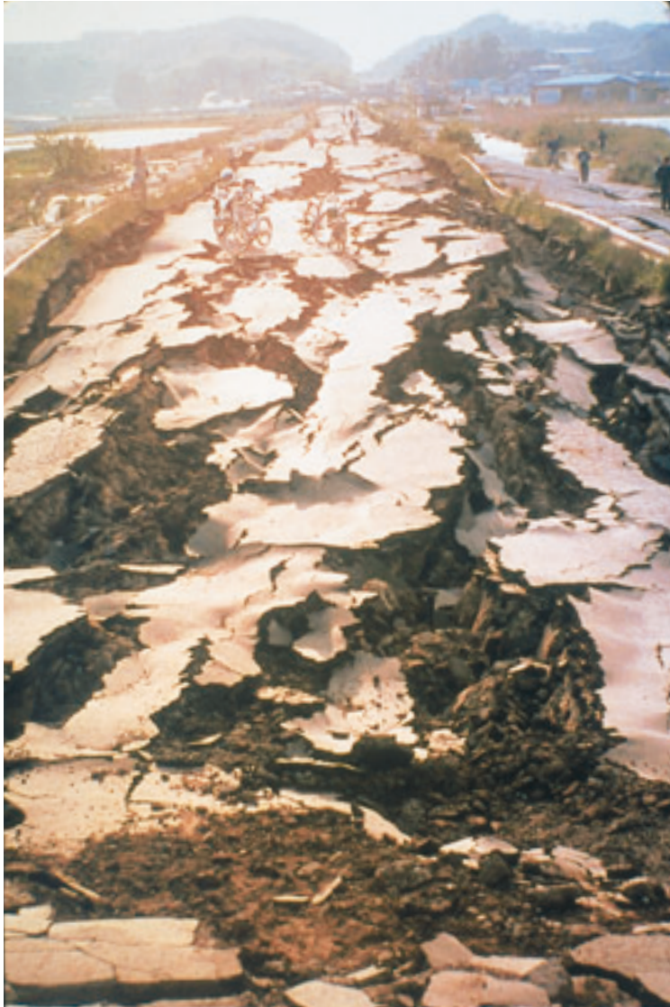
写真-1 五光明橋取付部の崩壊
