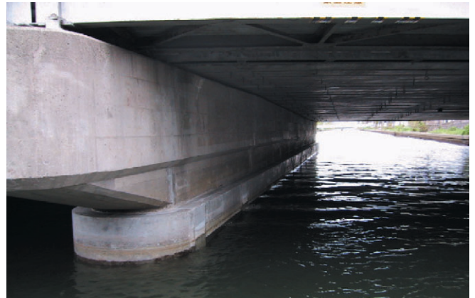
写真-3 界橋完成状況
