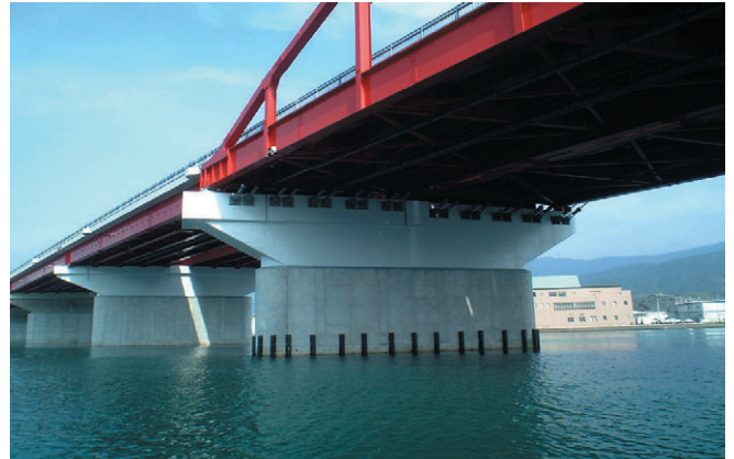
写真-2 早岐瀬戸大橋完成状況
