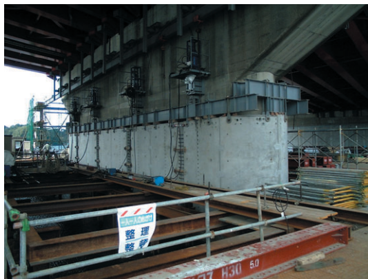
写真-4 プレキャストパネルの一括沈設システム
