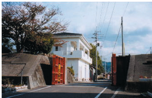
写真-7 広川町大字広に設置されている津波防止用のゲート(赤門)
