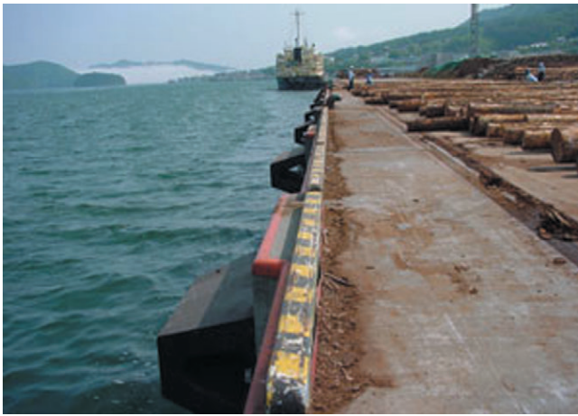
写真-4 岸壁法線および木材の野積み状況
