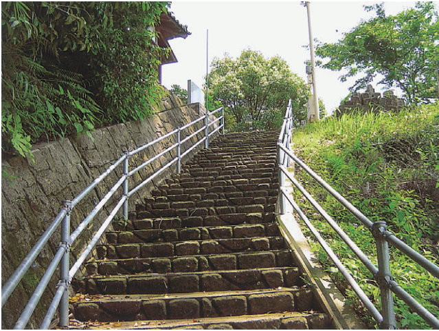
写真-4 整備された避難路と蓄電型外灯
