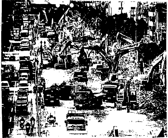
写真-1 深江地区道路啓開作業
