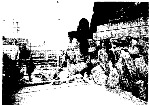
写真一2 写真一1の延長上の断層であるが、断層の通過した石垣、道路コンクリート舗装は壊れているが、隣接した石垣は全く無被害である。
