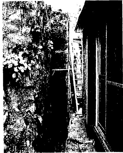
写真一4 正面スケールのあててある岩の面が断層面で約20cmずれて、その延長が右の家屋の床下を通ったが、家屋はゆがんだだけで、倒壊はしなかった。庭の盆栽は棚から落ちなかったので加速度は大した事は無かったのかもしれない。
