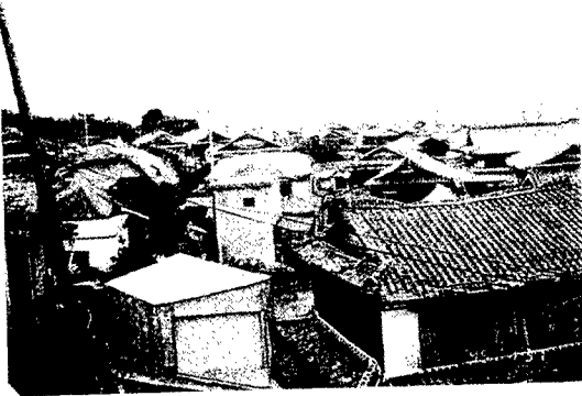
写真一3 写真一1, 2から数100m離れた海岸砂質低地では、木造家屋にかなりの被害が見られる。
