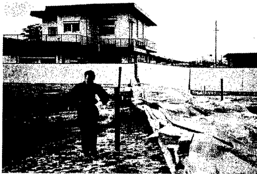
写真一1 ビニール・シートのかけてある断層の通過した塀は壊れているが、その断層から30cm離れた二階家は、窓ガラスも割れていない。(1995年兵庫県南部地震、野島断層、M7.2)
